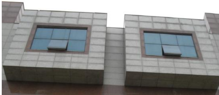
Şekil 4. Bina cephesi seramik kaplama
