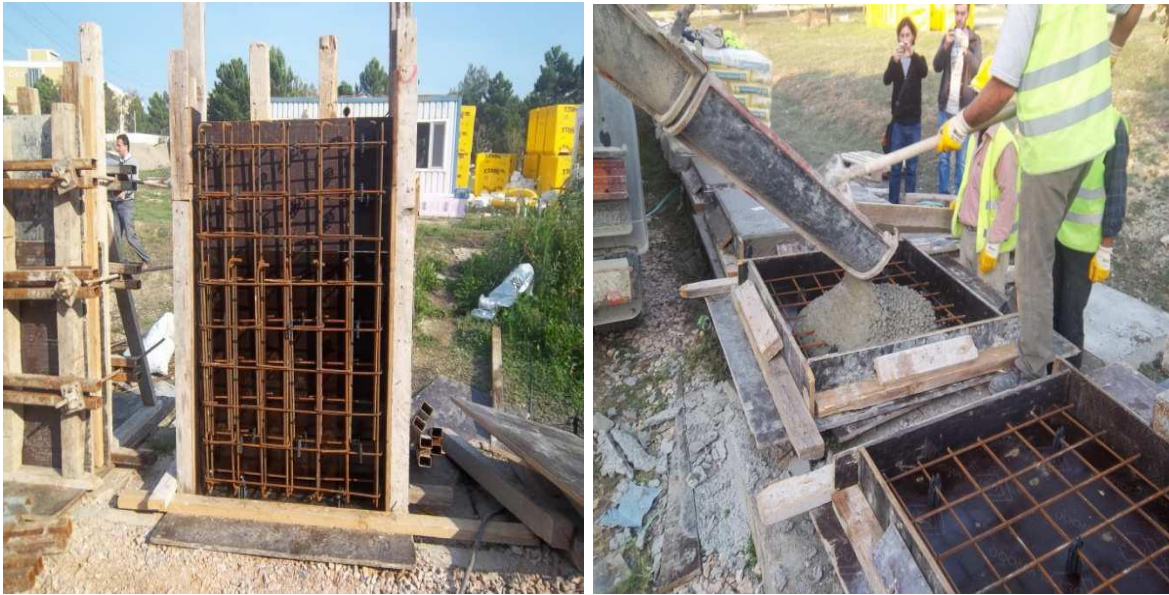
Şekil 3. C20/25 ve C30/37 sınıflarında hazırlanan perde ve döşeme elemanları
