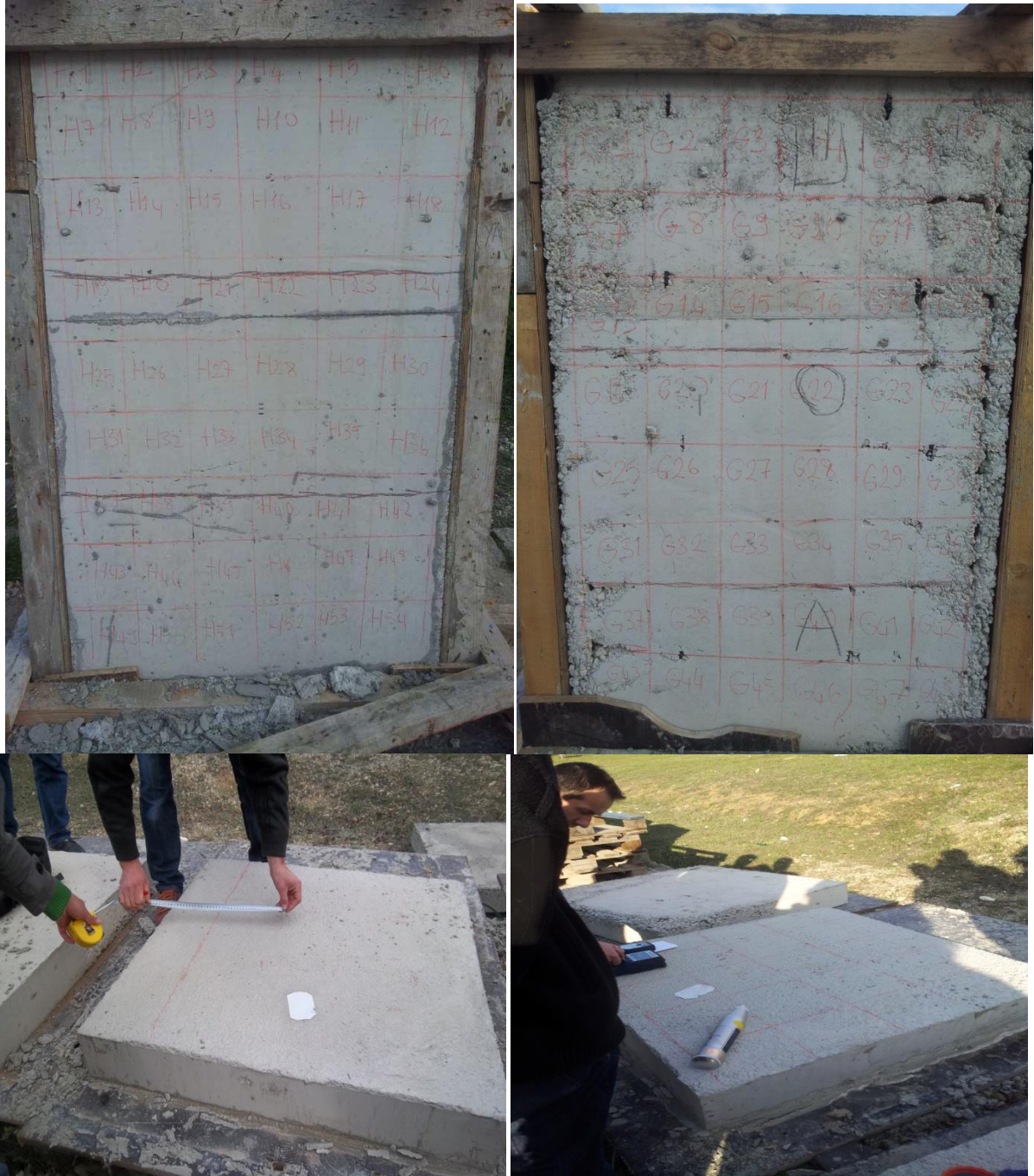
Şekil 2. Perde ve döşeme elemanlarda karot alınacak yerlerin işaretlenmesi
