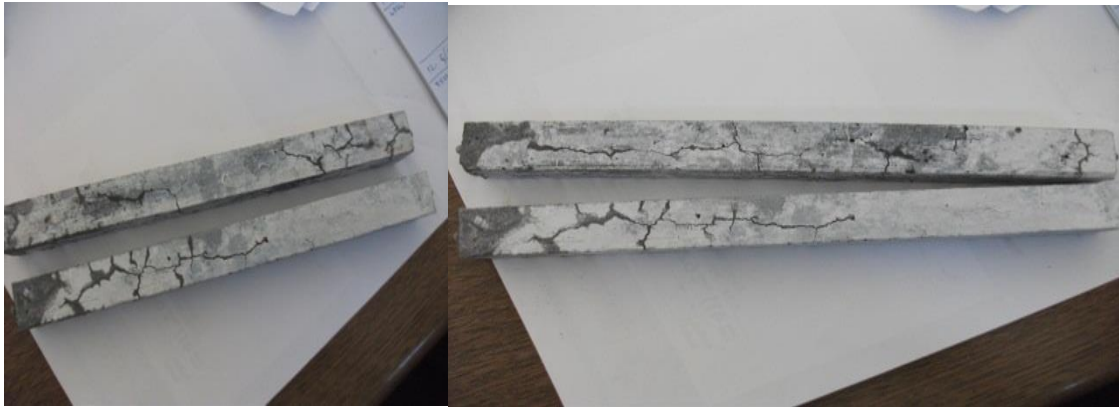
Şekil:5 28 günlük ASR Çatlakları
