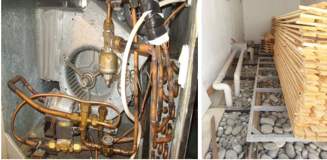
Şekil A.4. Nem Alma Ünitesinin İçerisinde Sirkülasyon Pompası ve Evaporatör (solda) Kurutma Fırınının İç Görünüşü (sağda),
