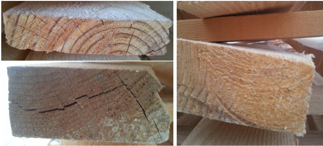
Şekil B.2. Bazı Kerestelerde Oluşan Çatlaklar ve Burulma
