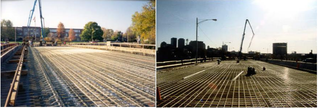
Şekil 2. Köprü döşemesinde GFRP donatıların kullanımı [14]
