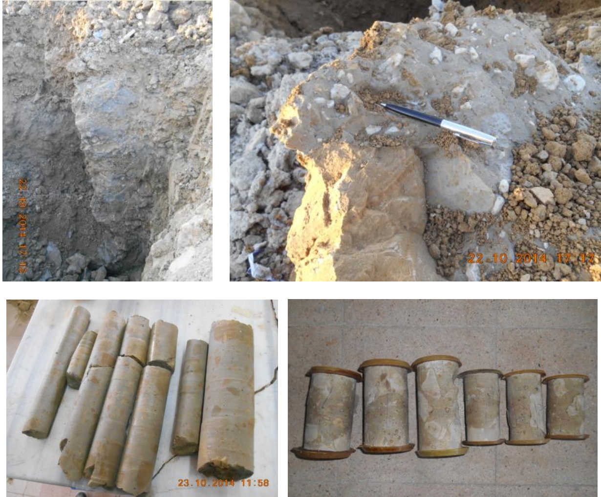
Foto 9. Jet grout kolonu, alınan numuneler ve kırılmış halleri
