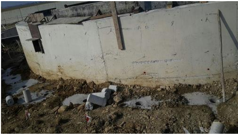
Foto 7. Temelde jet-grout öncesi karotiyerle delme işlemi
