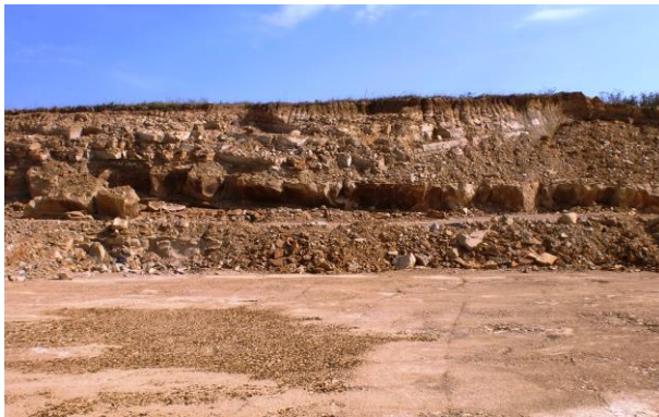
Foto 2. Dolgu malzemesinin alındığı doğal yamaç ve tabanda serilmiş dolgu
