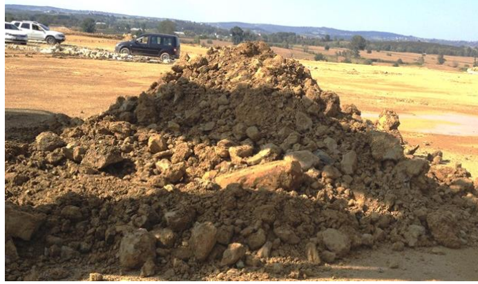
Foto 5. Dolgu içinde bulunan iri bloklar
