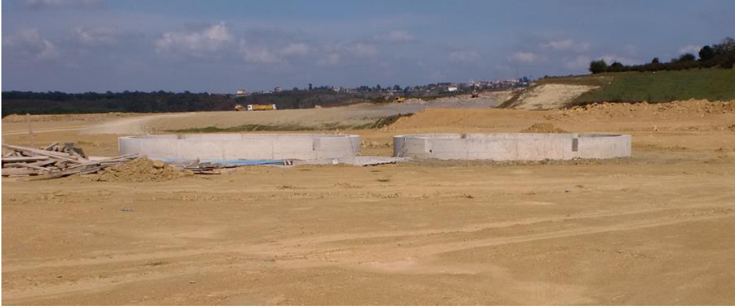
Foto 1. Dolgu alanı ve silo temelleri
