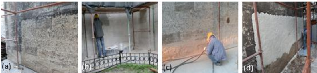
Şekil 4. Dış cephede uygulama: (a) kir atıkları, (b) yüzey temizliği, (c) kumlama, (d) kabuk hamuru ile temizlik
