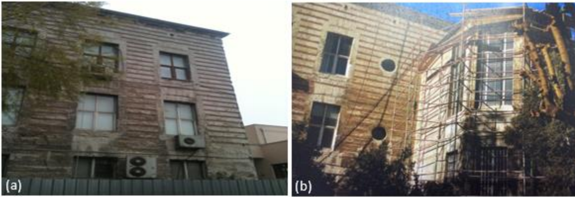
Şekil 2. Yapı dış cephe: (a) küfeki taş yüzey kirliliği ve tahribatı, (b) basit onarımlar
