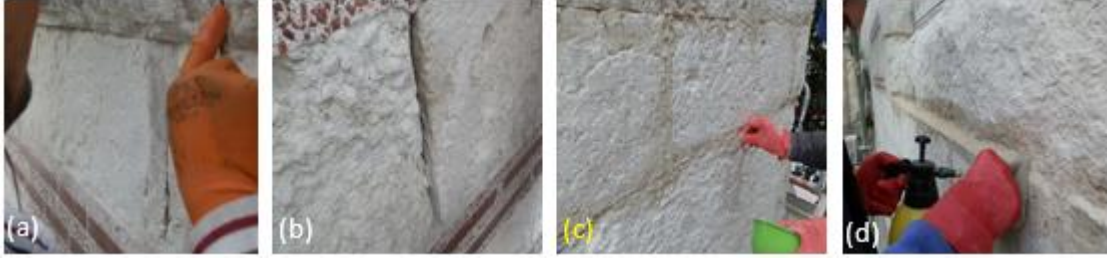
Şekil 5. Derz dolgu uygulama safhaları: (a) derz aralarının açılması, (b) derz temizliği, (c) derz dolgusu yapılması, (d) tel fırça ile düzeltilip kimyasal uygulama ve silinmesi
