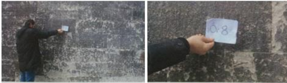
Şekil 3. Tarihi yapının dış cephe yüzeyindeki kir tabakası
