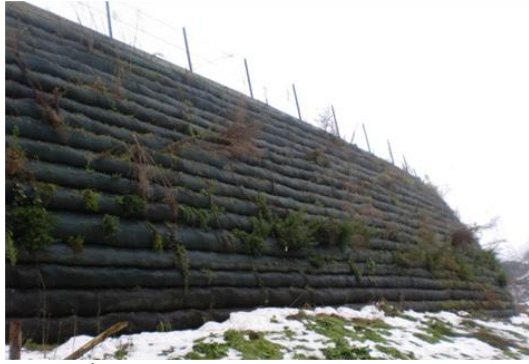
Foto 1. İncelenen donatılı zemin yapısı
