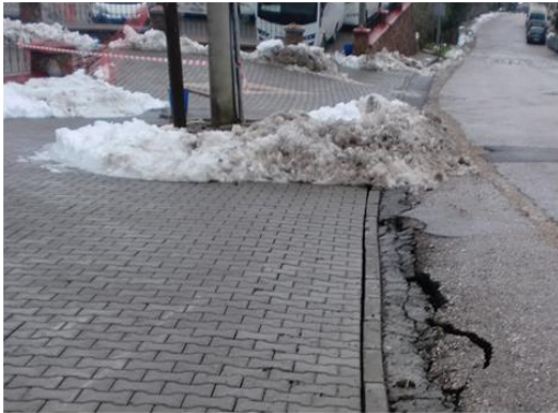
Foto 2. Yol sınırında gerçekleşen ayrılma
