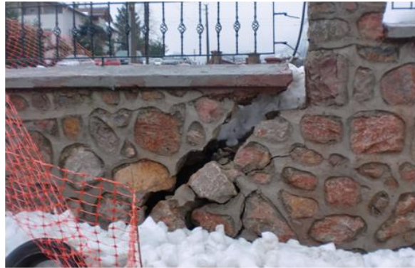
Foto 3. Dolgu üstü duvarda gerçekleşen ayrılma
