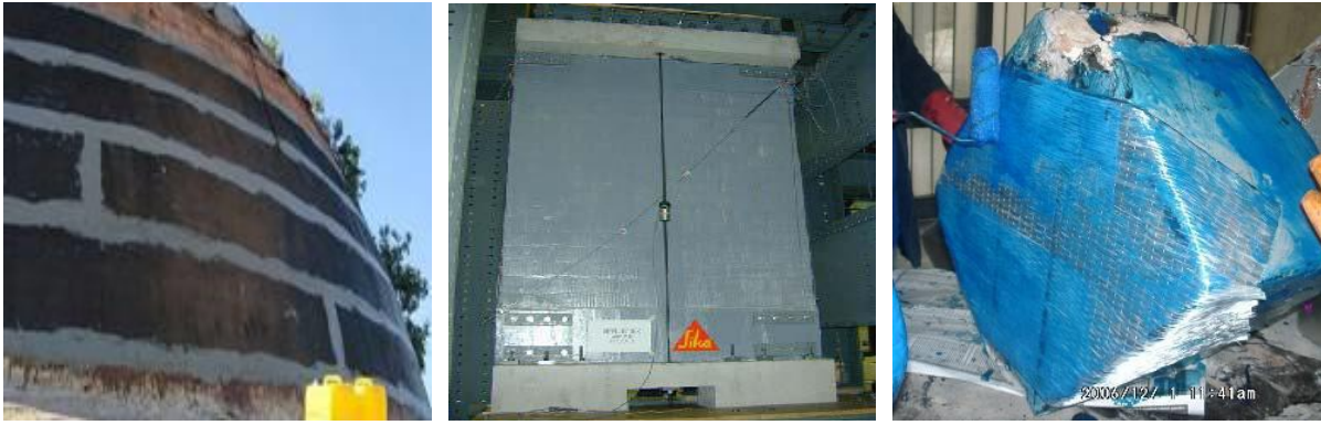
Şekil 6. Kumaşlar sarılarak yapılan duvar güçlendirmeleri [17-19]
