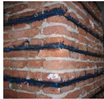
Şekil 2. FRP şerit derz uygulaması [2]
