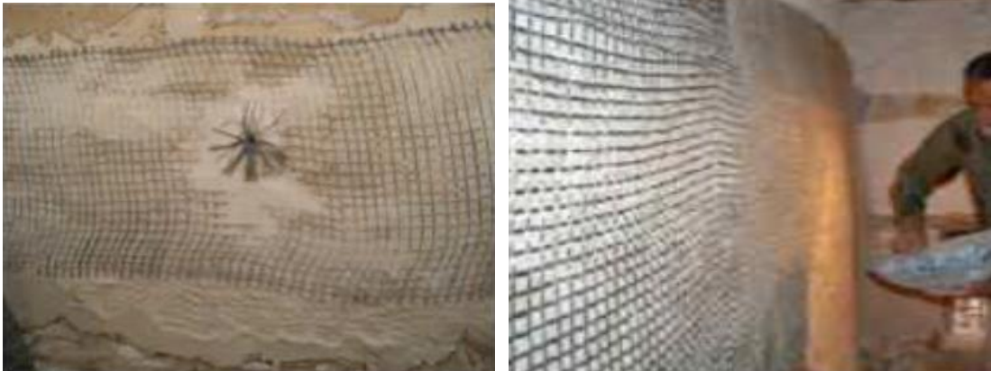
Şekil 4. Bazalt elyafı ile donatılı harç uygulaması [12]
