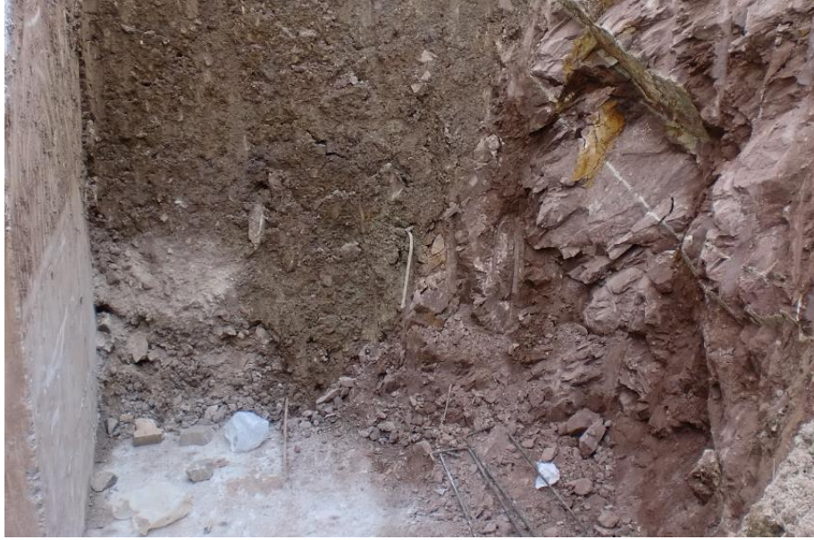
Şekil 3. Duvar arkasındaki doğal zemin ve kazılıp dolgu malzemesi olarak kullanıldıktan sonraki hali
